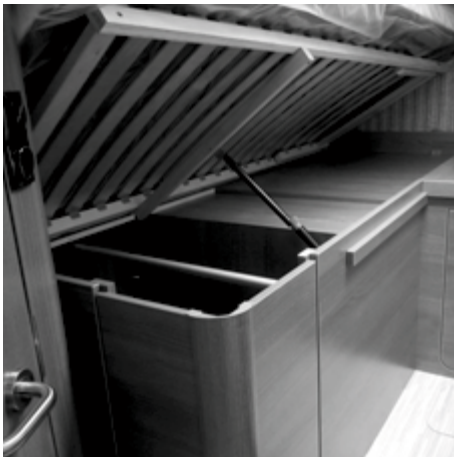
Fig. 44 : Amortisseur à pression de gaz
