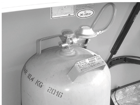
Fig. 71 : Bouteille de gaz avec détendeur basse pression et flexible basse pression
