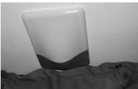
Bild 144: Montera lampkåpan
