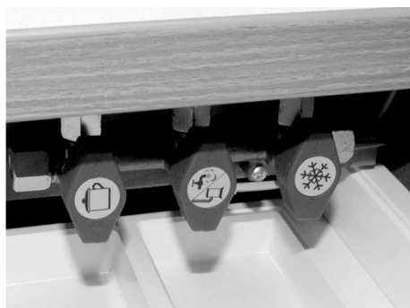
Fig. 91: Vannes d'arrêt rapides
